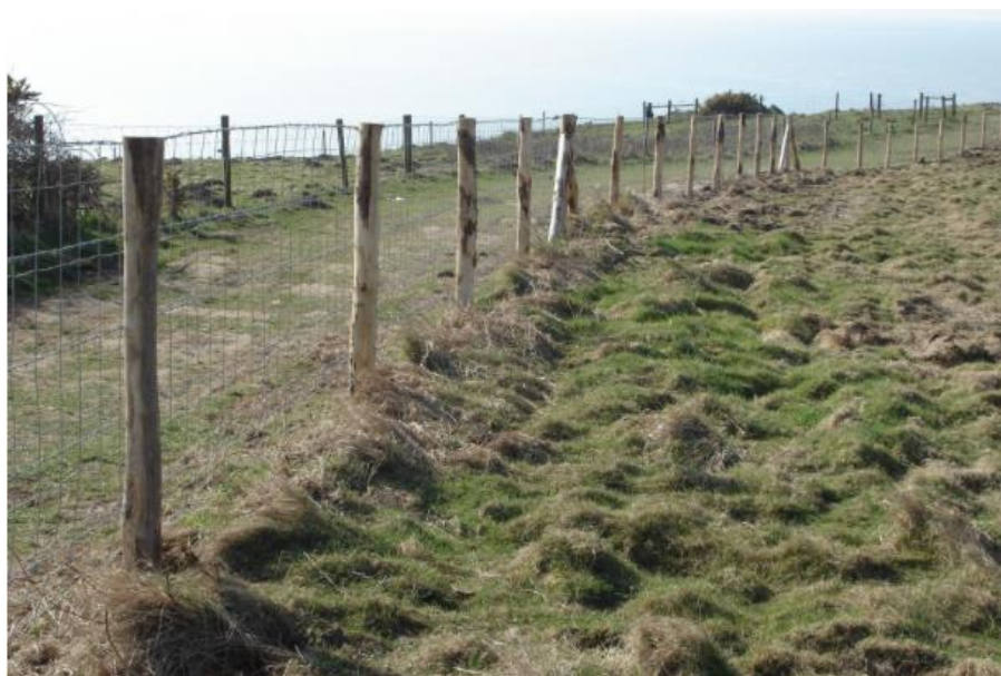
Figure 7 : Exemple de clôture de type herbagère
